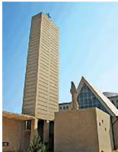
Рис. 2. Церковь Непорочного зачатия, г. Баку, дата основания – 2006
